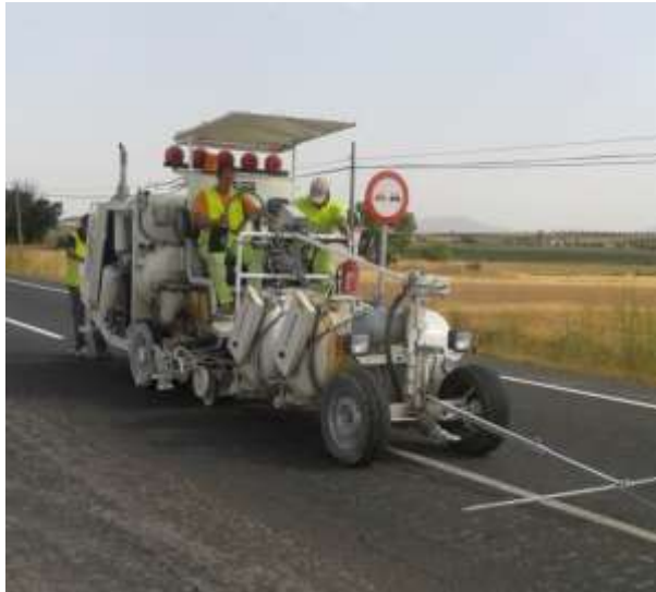
Señalización Horizontal: pintura
